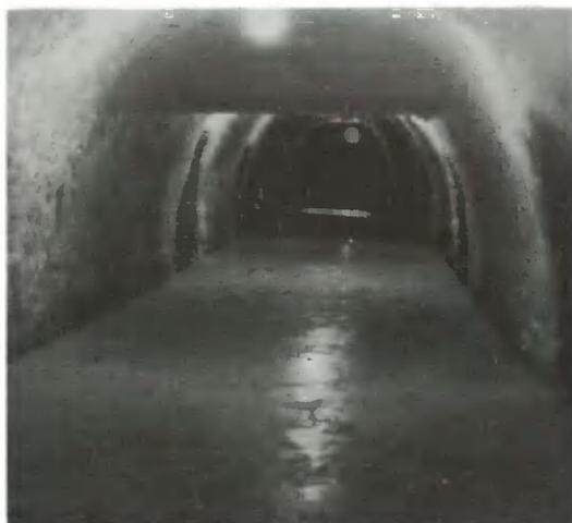
Горные выработки на севере Тюменской области, пройденные в мерзлых горных породах для хранения мороженой рыбы. Отрицательная температура пород с одновременным проветриванием холодным зимним воздухом позволяет поддерживать в камере достаточно низкую температуру без применения холодильных машин.
